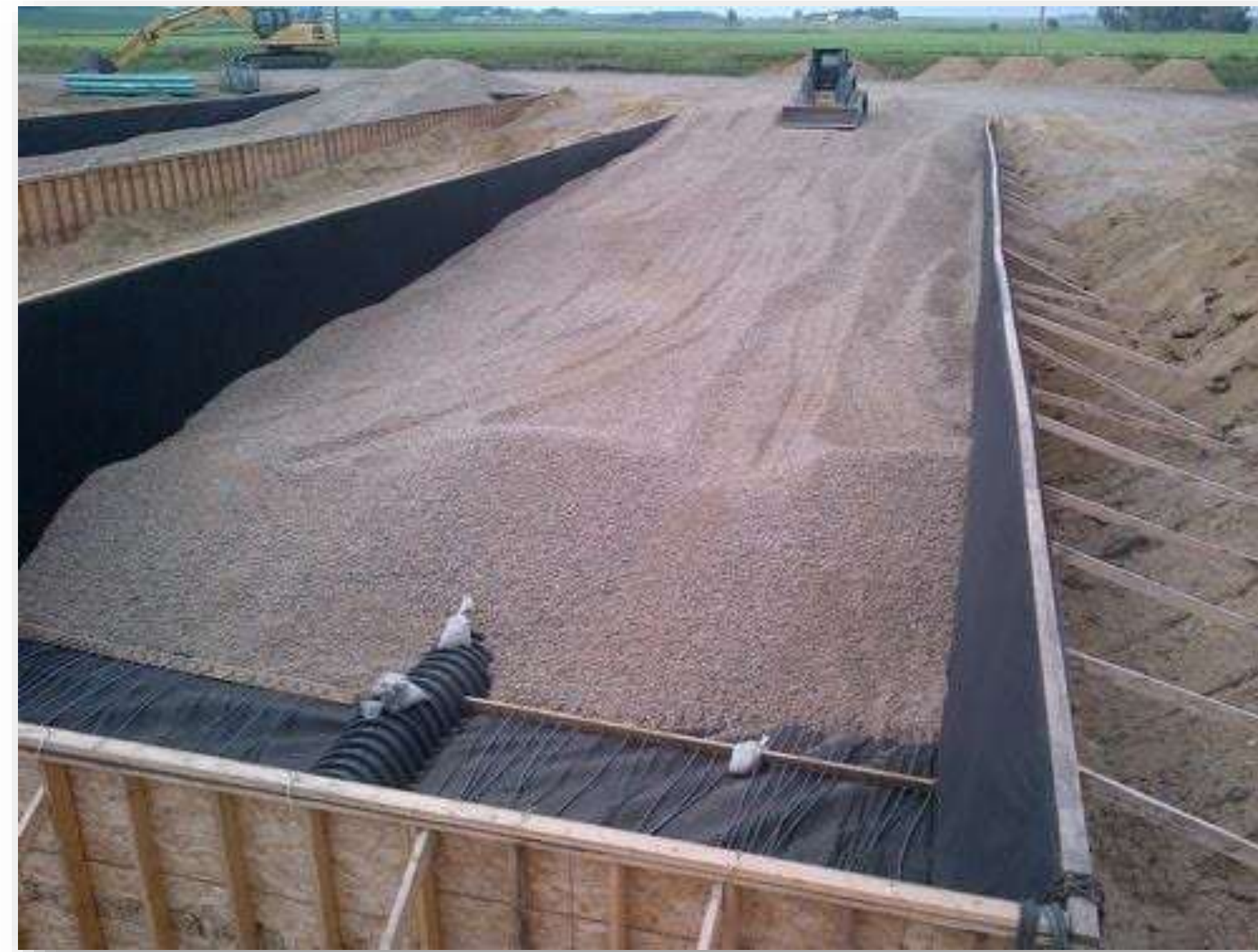
Construction de SAGR
