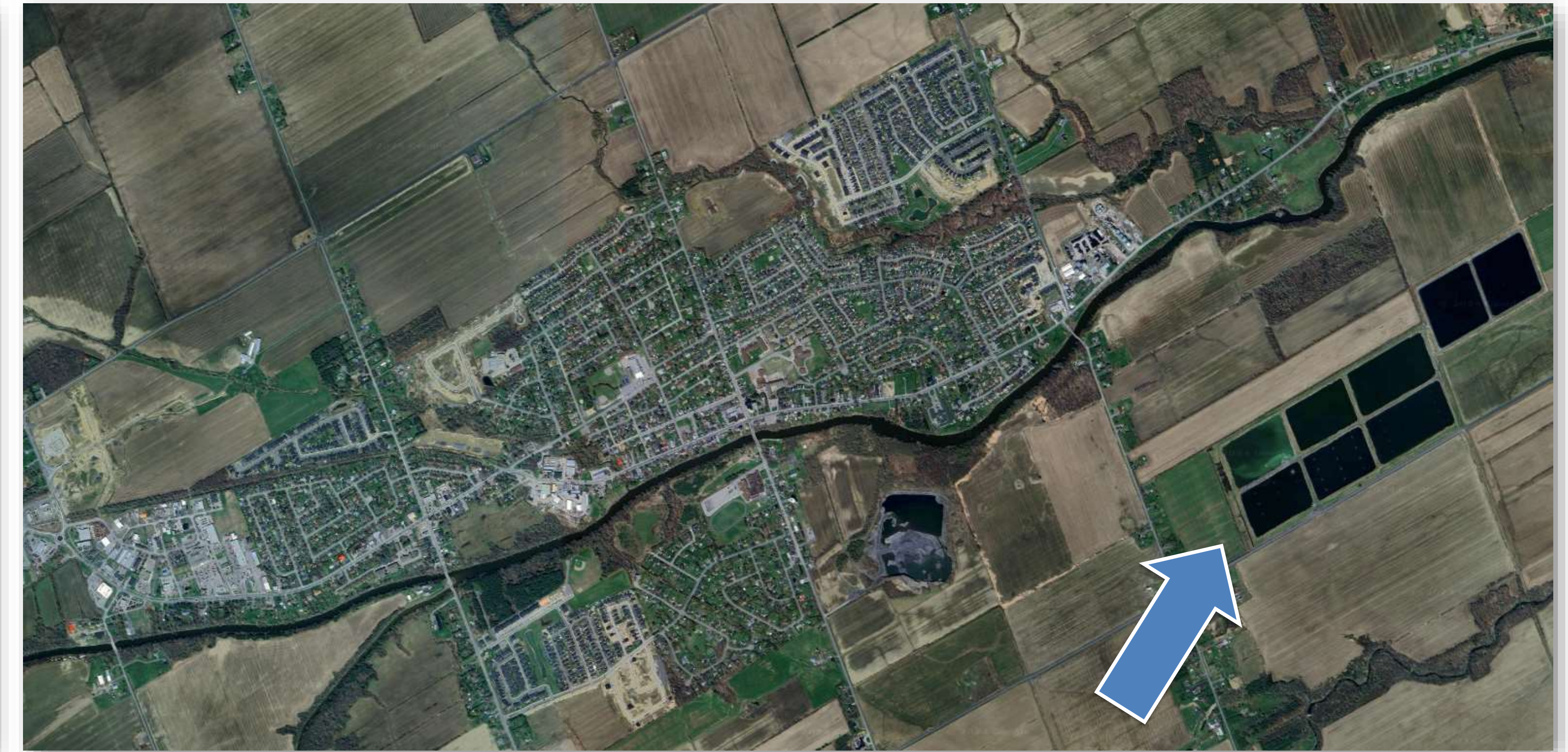
Station d'épuration des eaux usées d'Embrun
