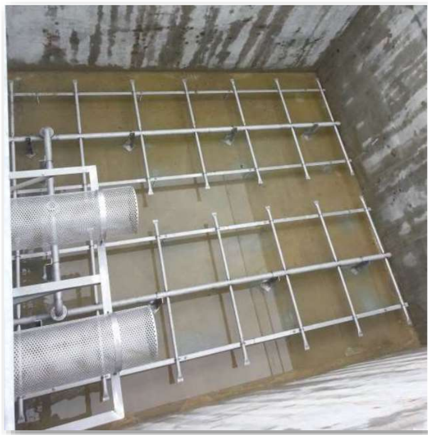
Réservoir de RBGS (en haut), les medias de RBGS (en bas)
