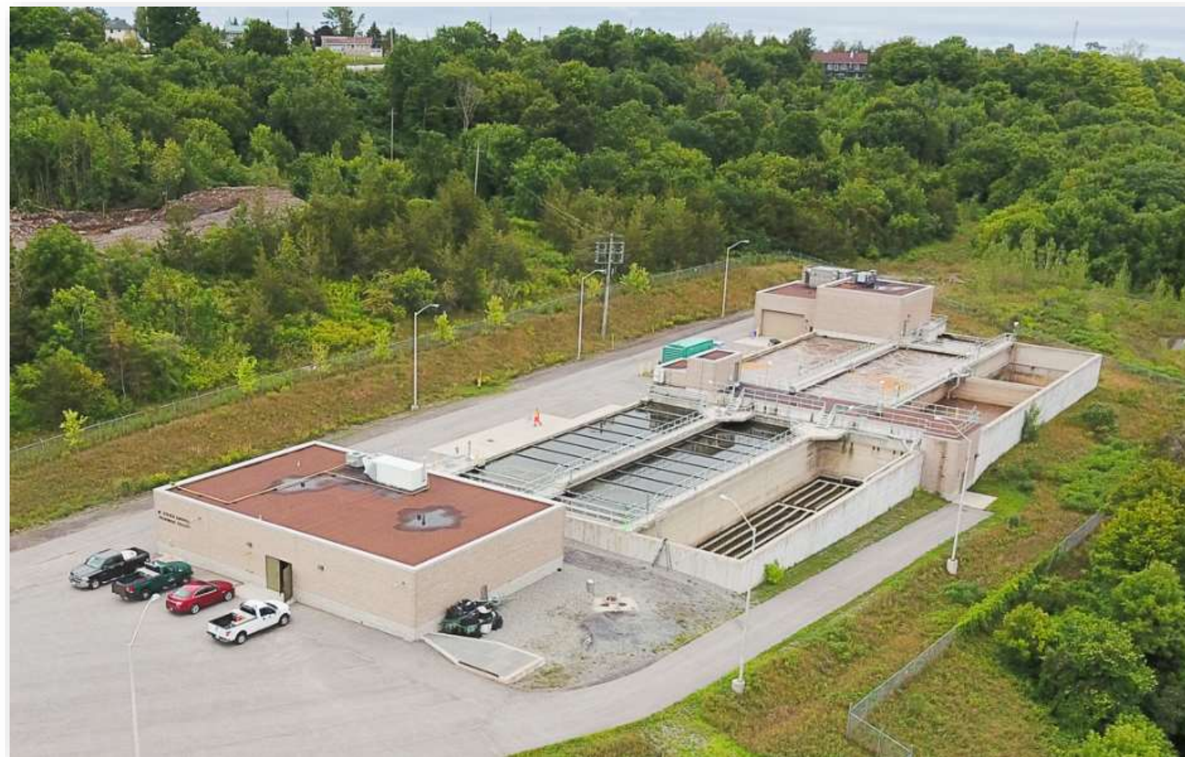
Station d'épuration des eaux usées mécanisée
