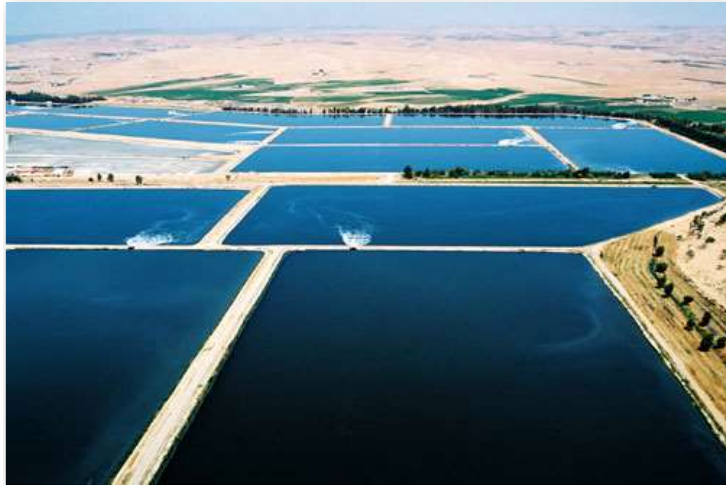
Traitement en étangs
