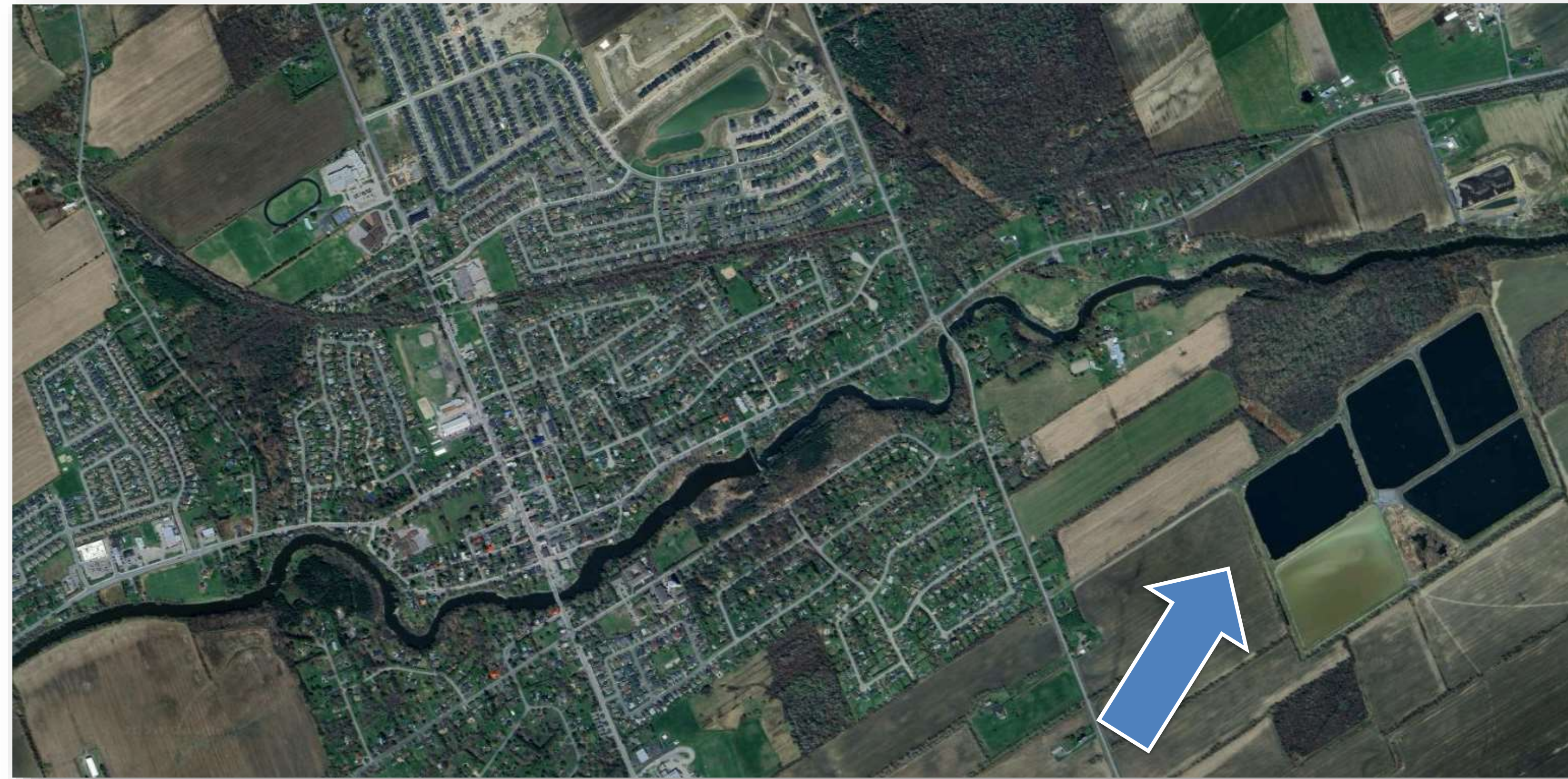
Station d'épuration des eaux usées de Russell
