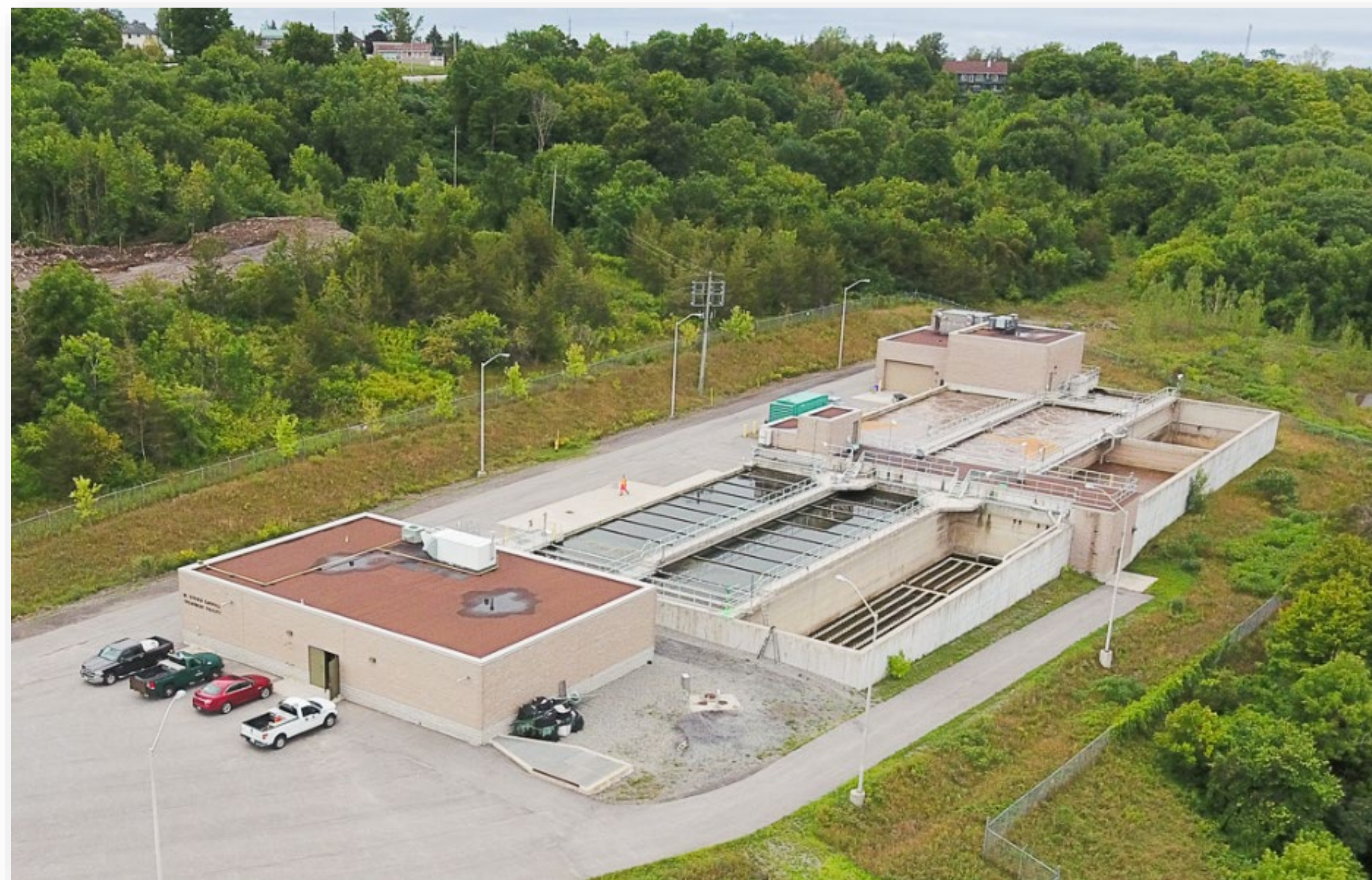
Station d'épuration des eaux usées mécanisée
