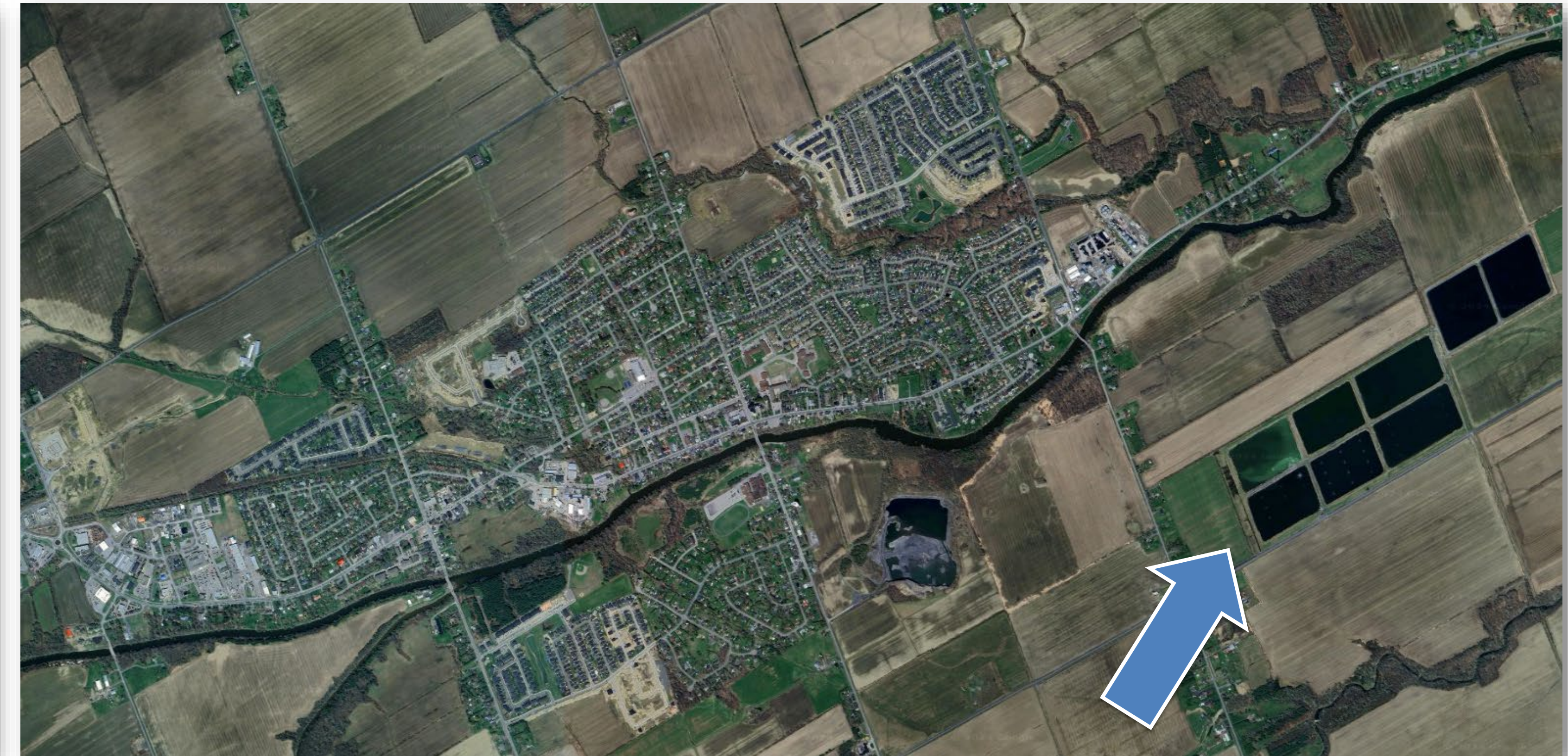
Station d'épuration des eaux usées d'Embrun
