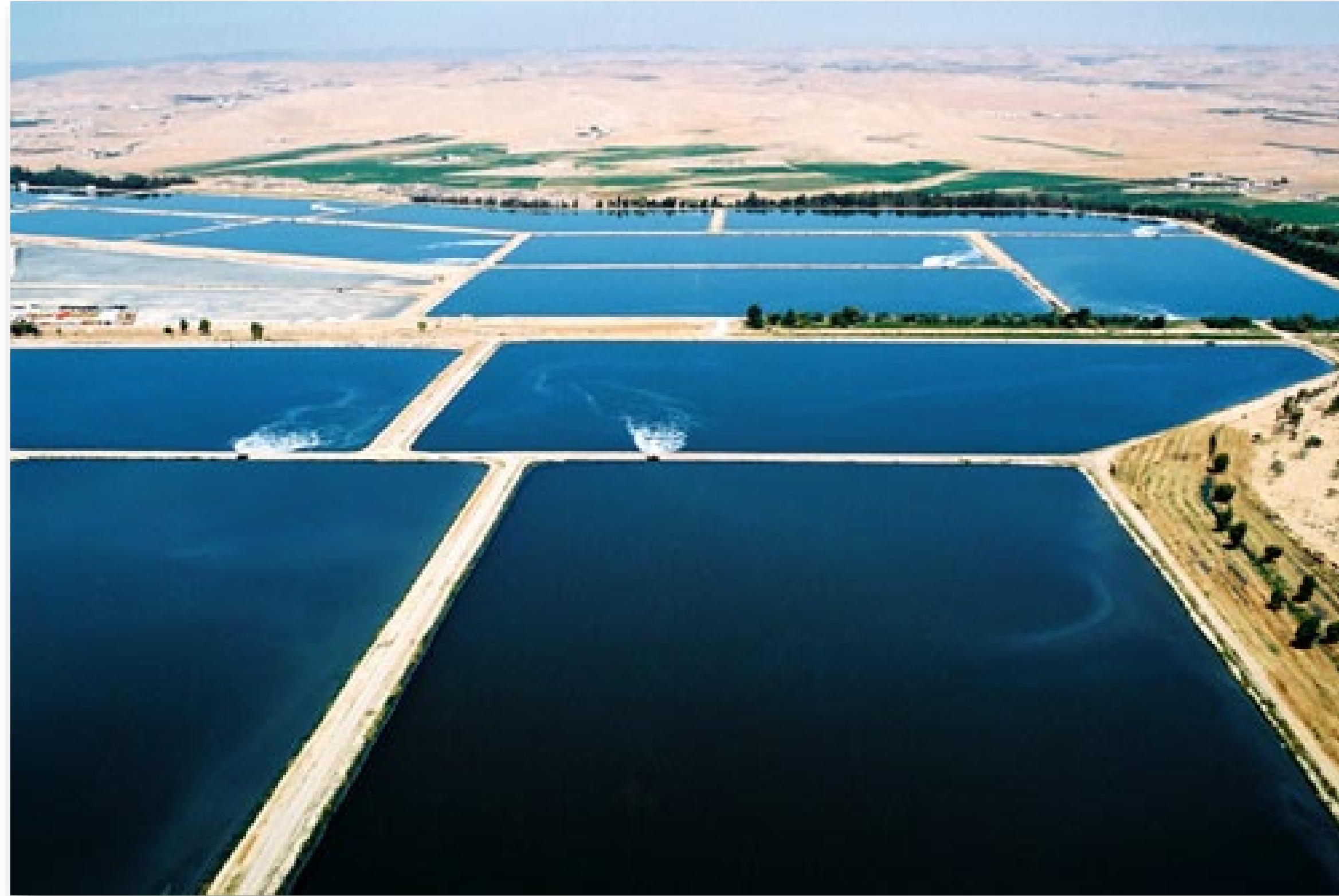
Traitement en étangs
