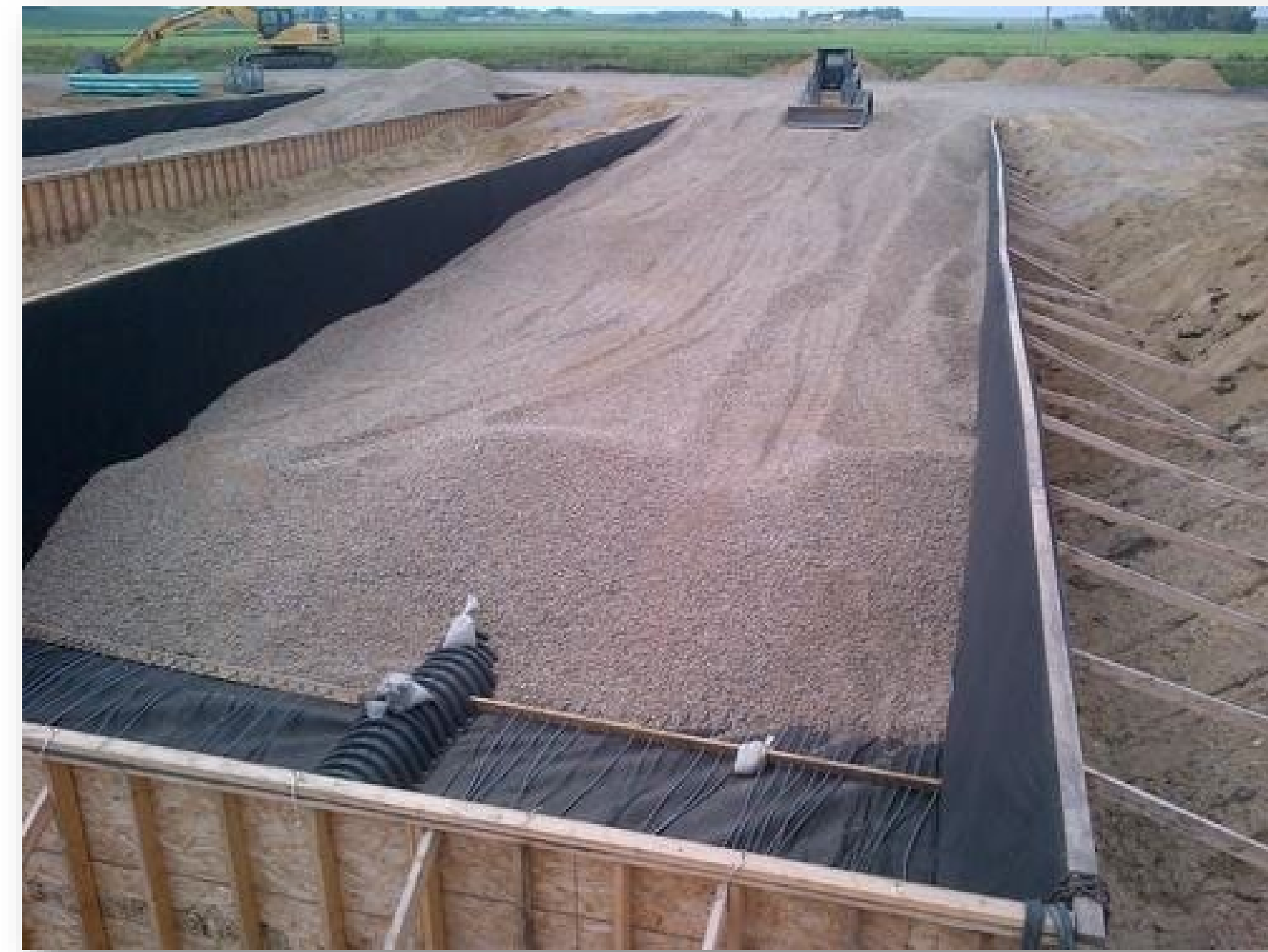
Construction de SAGR
