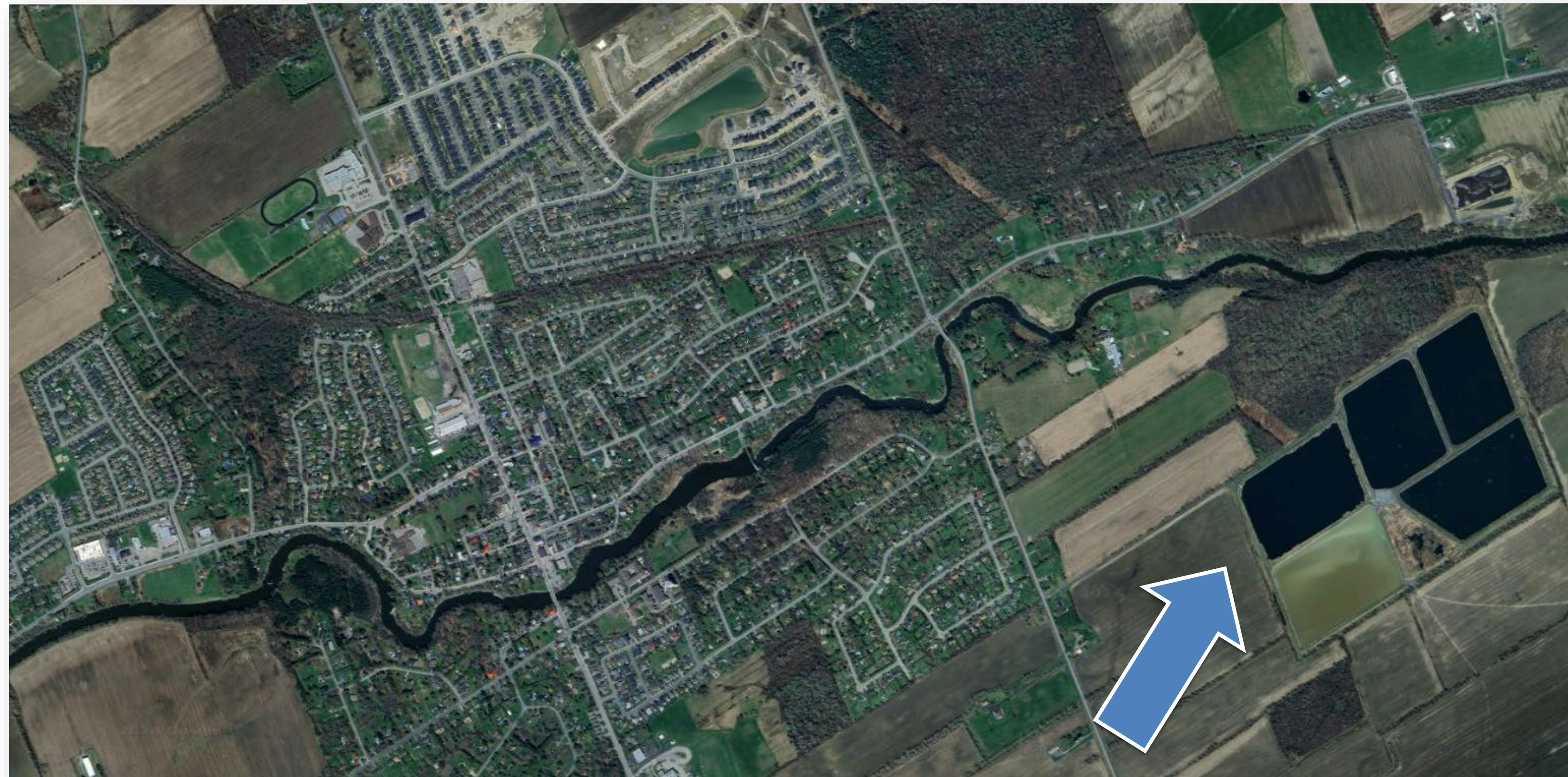
Station d'épuration des eaux usées de Russell
